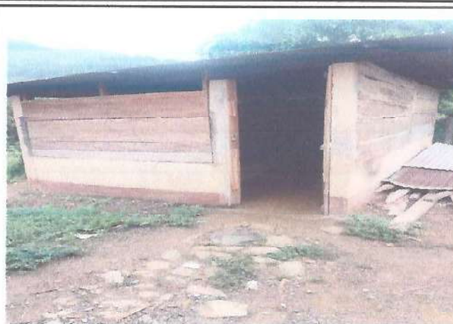
Foto 2: MEJORAMIENTO DE COCINA
