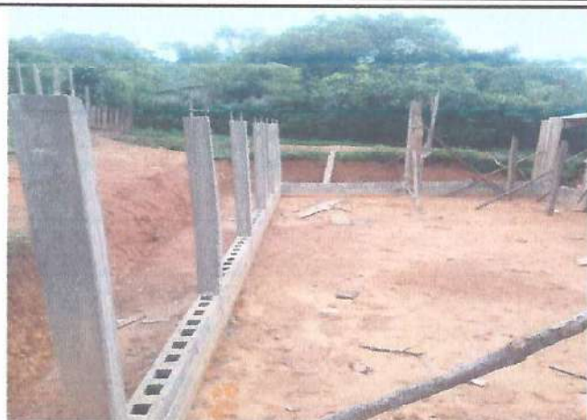
Foto 1: MEJORAMIENTO DE AULA AREA PORTICO
